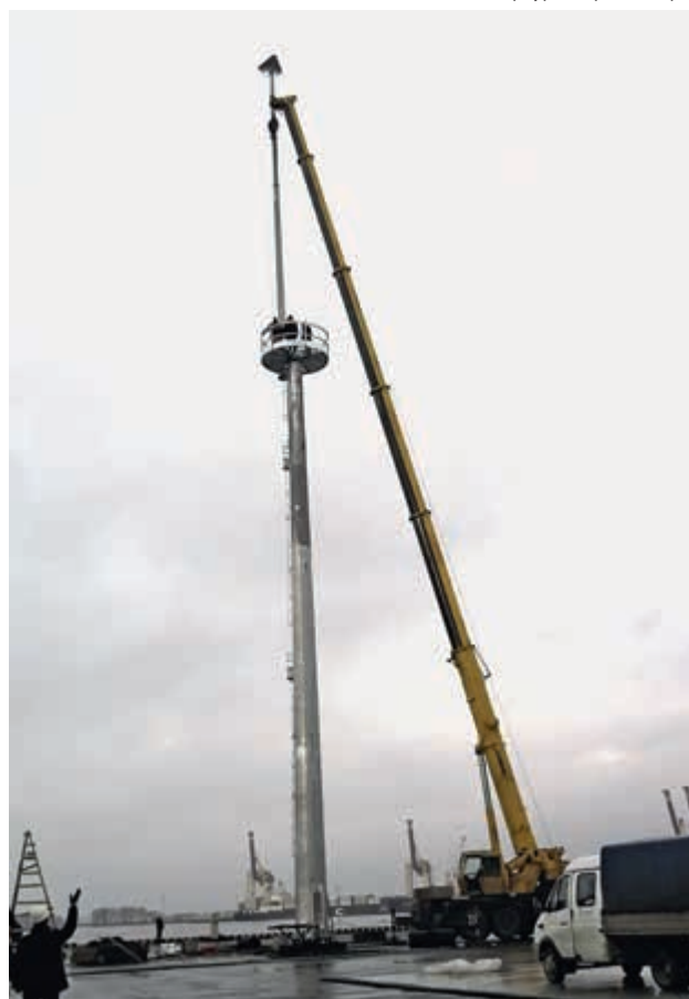
Монтаж мачты МГФ-СР-М, г. Санкт-Петербург, Морской порт
